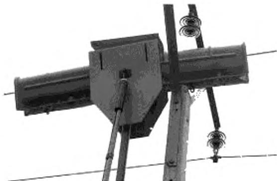
5.1.6 **чехол для штыревого изолятора (pin-type insulator cover):** Защитная оболочка, предназначенная для охвата штыревого изолятора.
